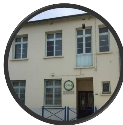
16 rue de la Binetterie
